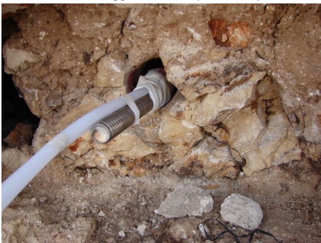
La testa dell'ancoraggio con calza prima e dopo l'iniezione della malta
